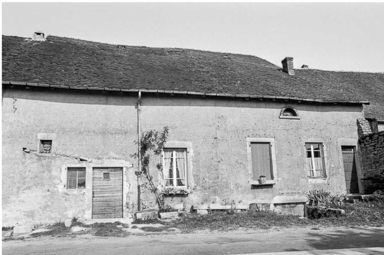
Ferme cadastrée D2 291 : façade postérieure.
