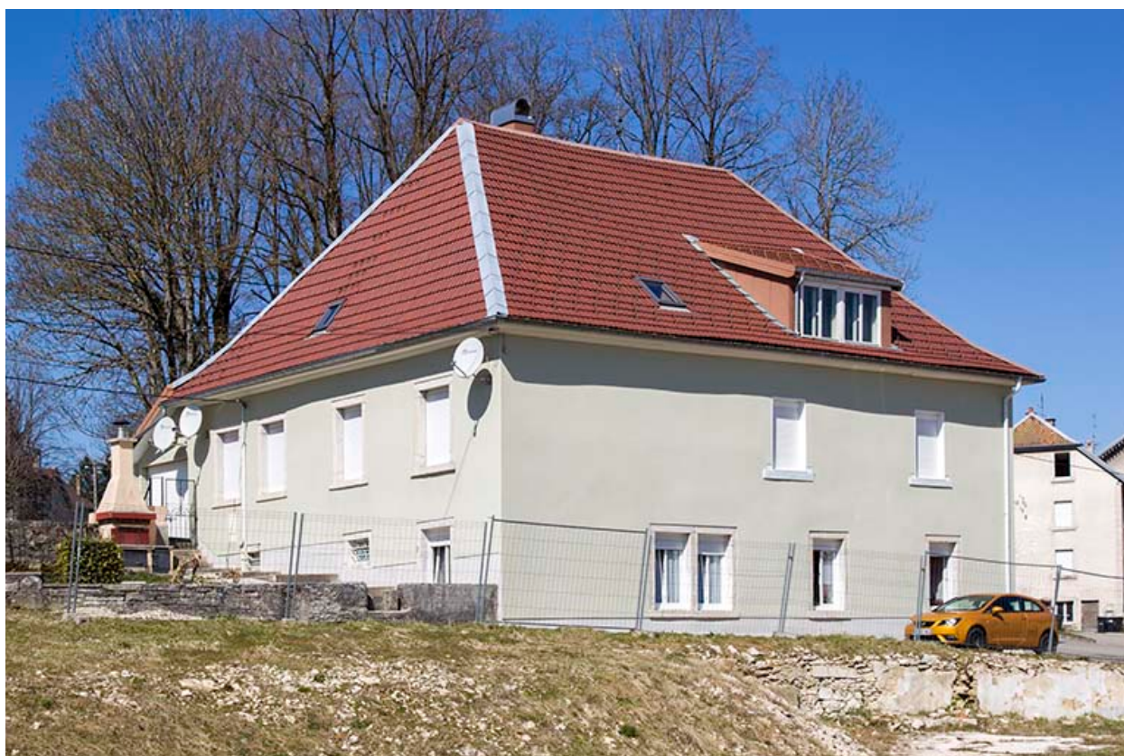
Façades postérieure et latérale droite.
