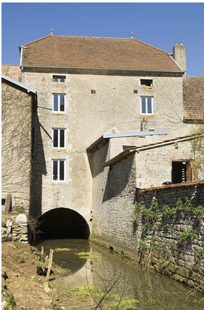
Façade postérieure depuis le bief d'aval.
