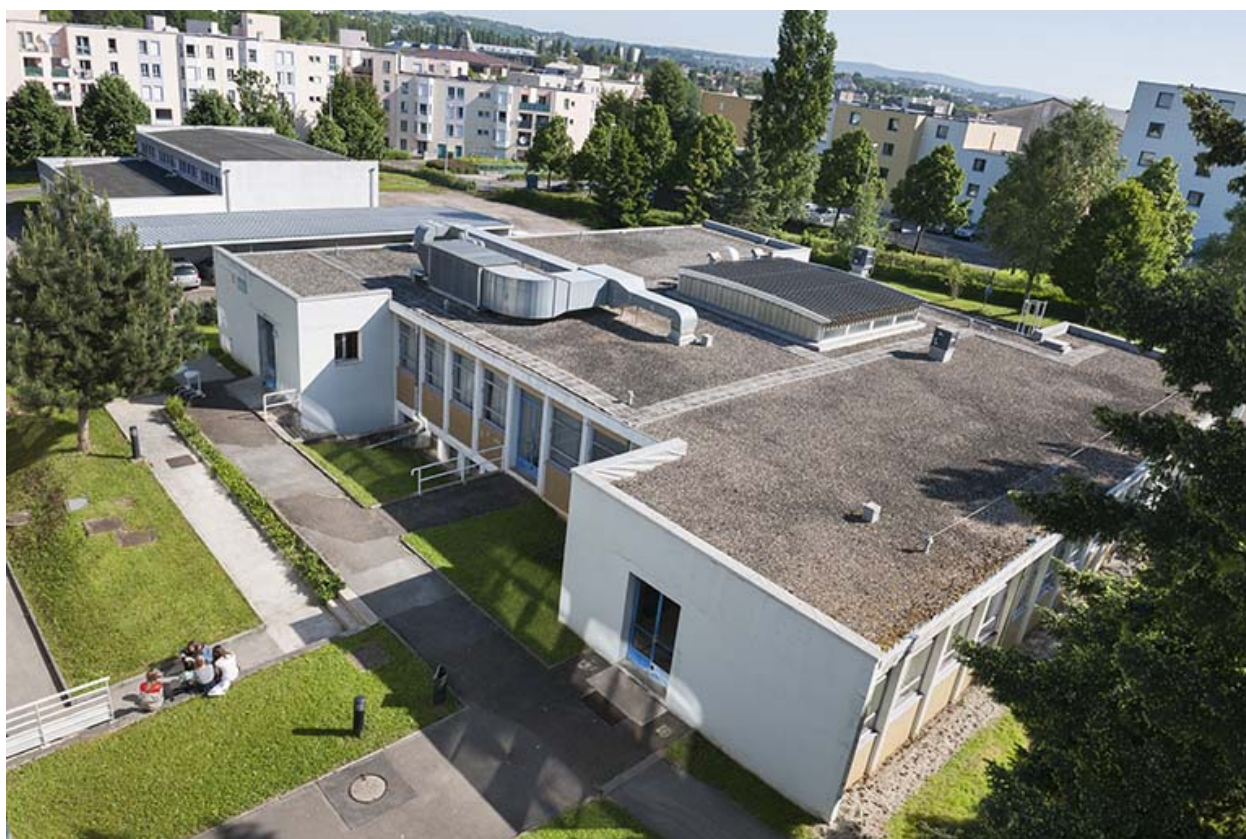
Angle sud-ouest du bâtiment de restauration.
