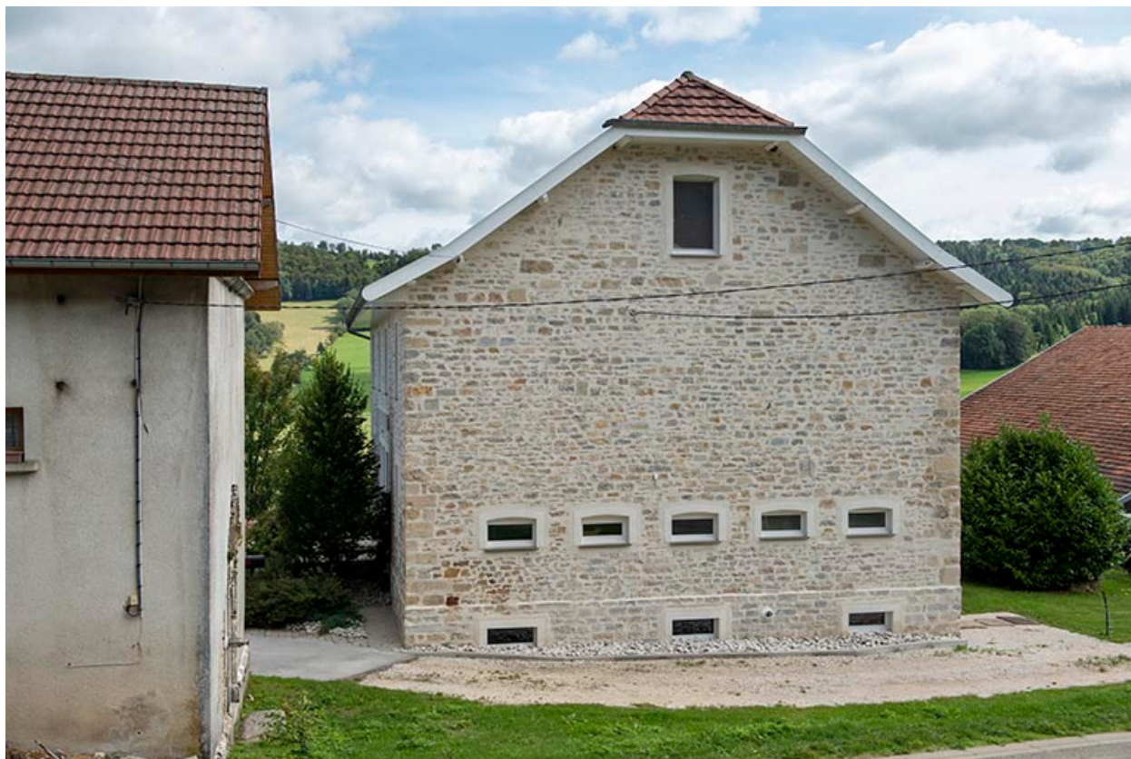
Façade latérale droite.
