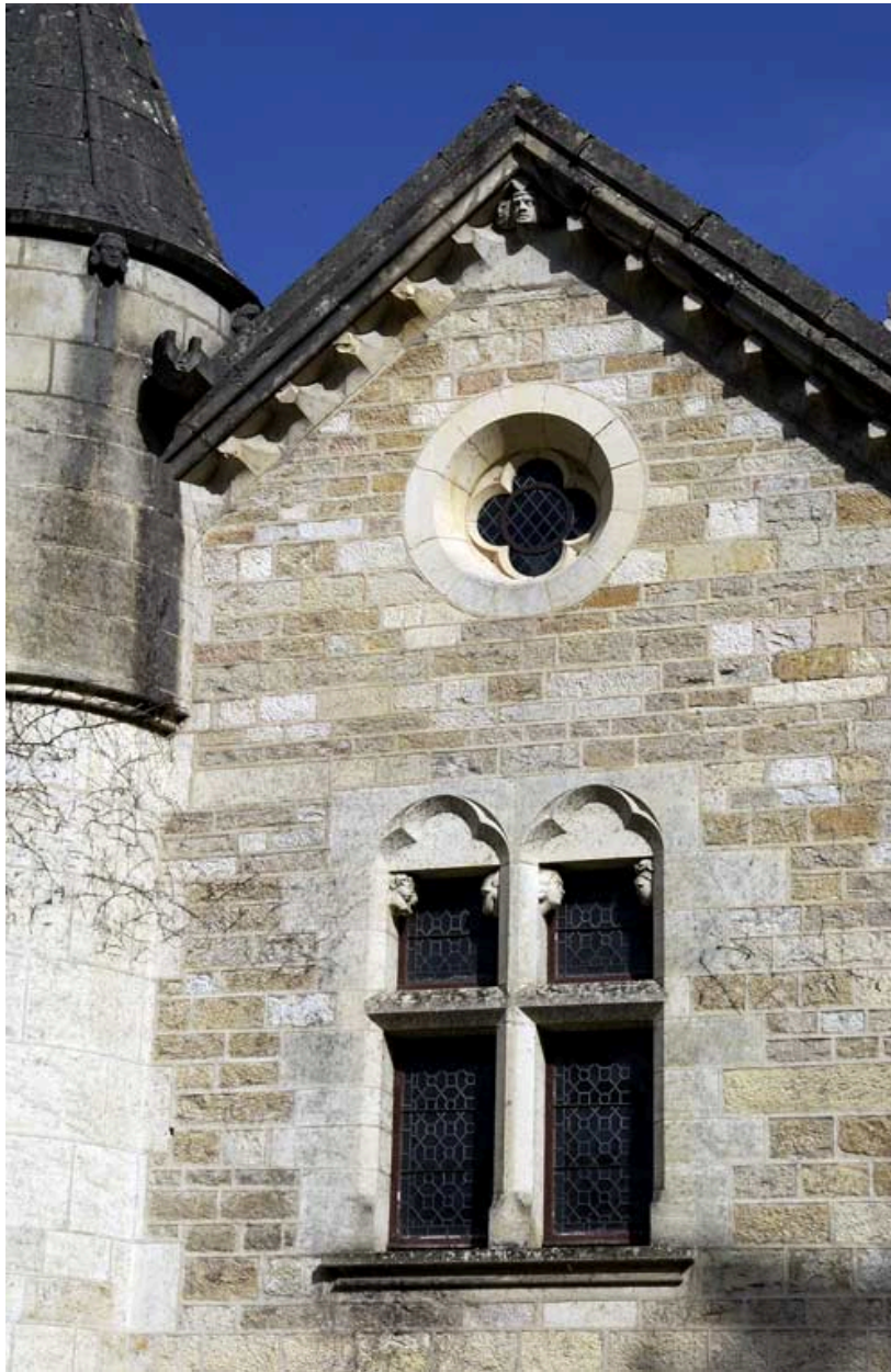
Aile en retour d'équerre à l'ouest du bâtiment du réfectoire : pignon ouest.
