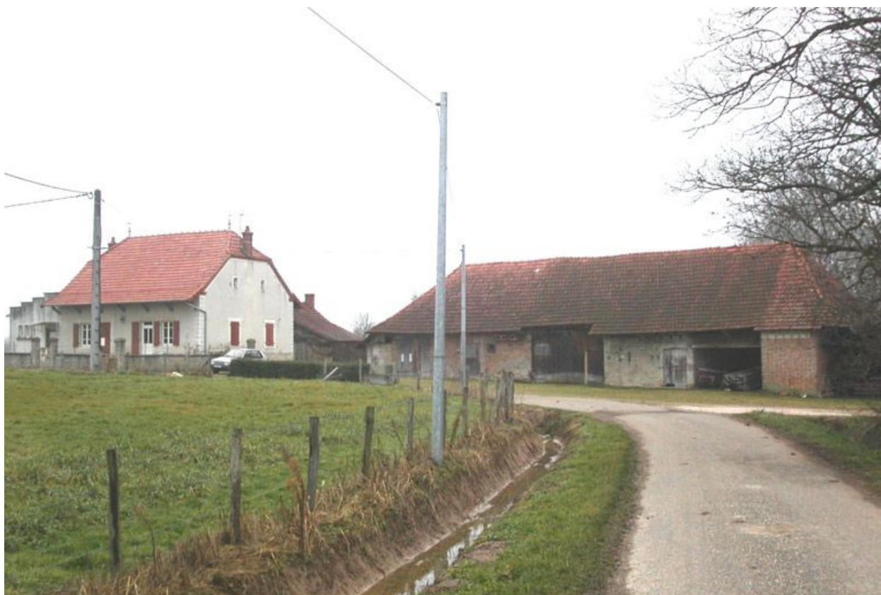
Vue d'ensemble de la façade.
