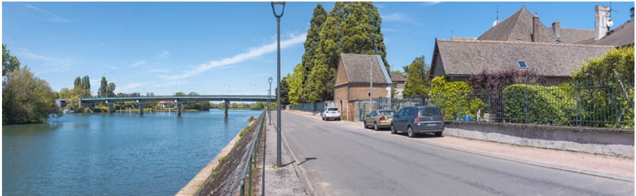
Vue d'ensemble du pont, depuis l'aval.
