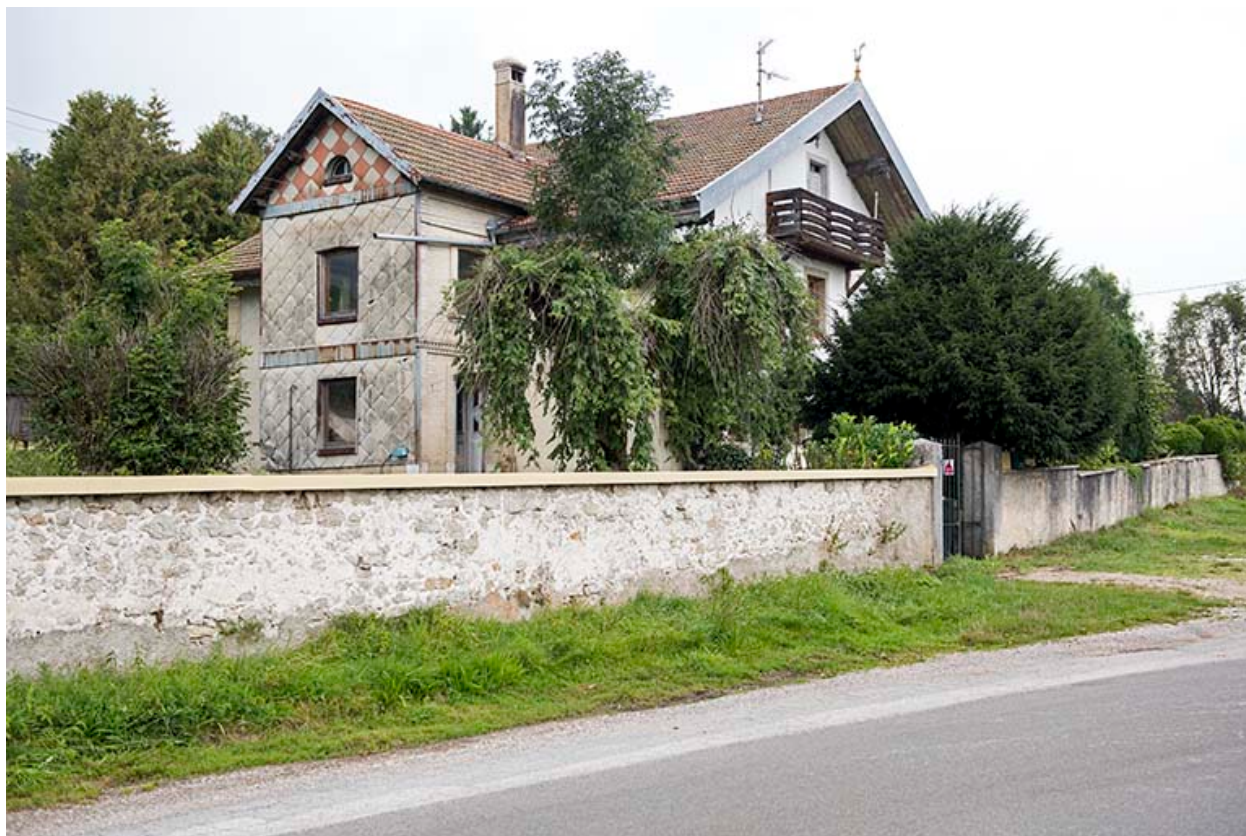
Façades antérieure et latérale gauche.
