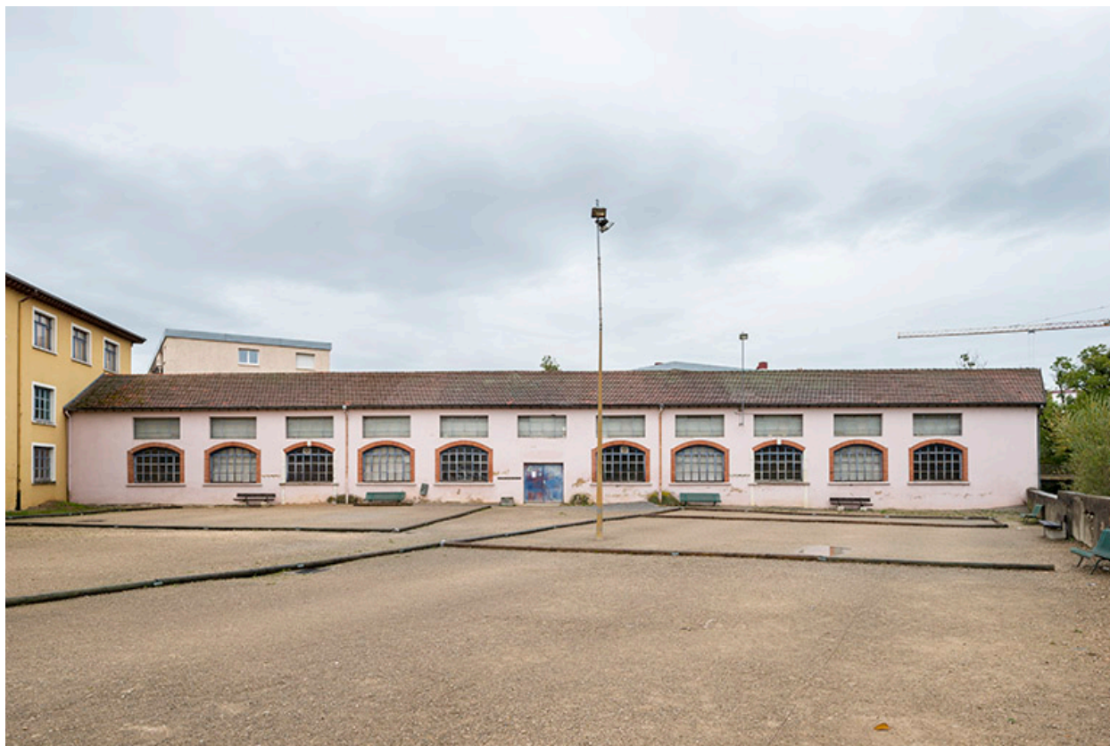
Bâtiment perpendiculaire à l'atelier principal. Façade sud.
