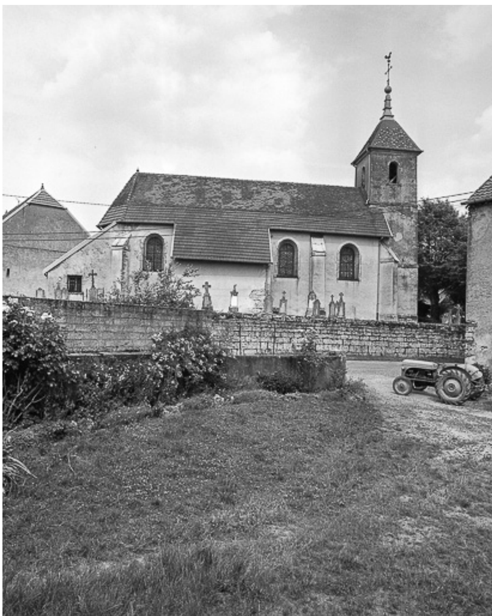
Façade latérale gauche.
