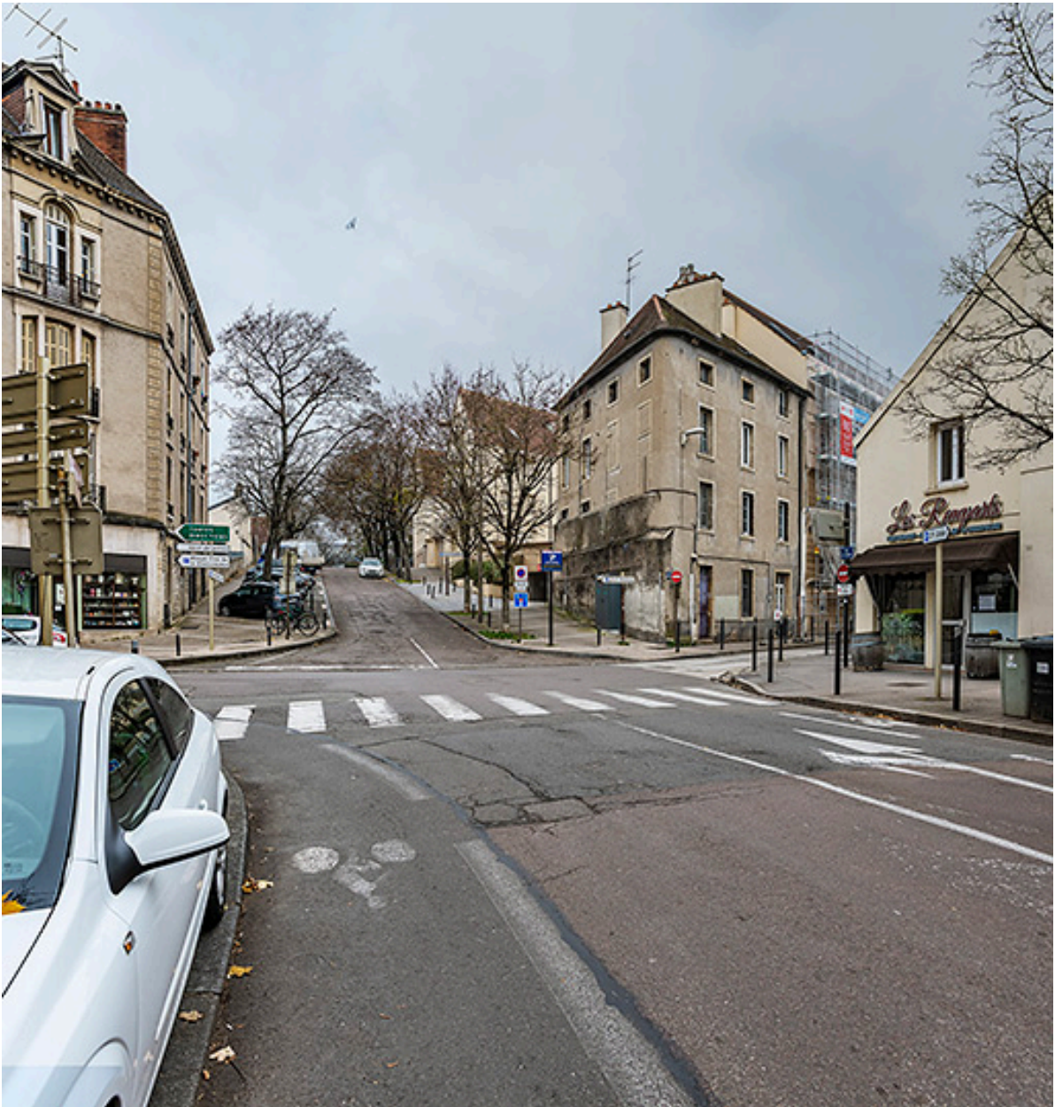
La montée vers la plateforme du bastion de Guise, rue de Tivoli.
