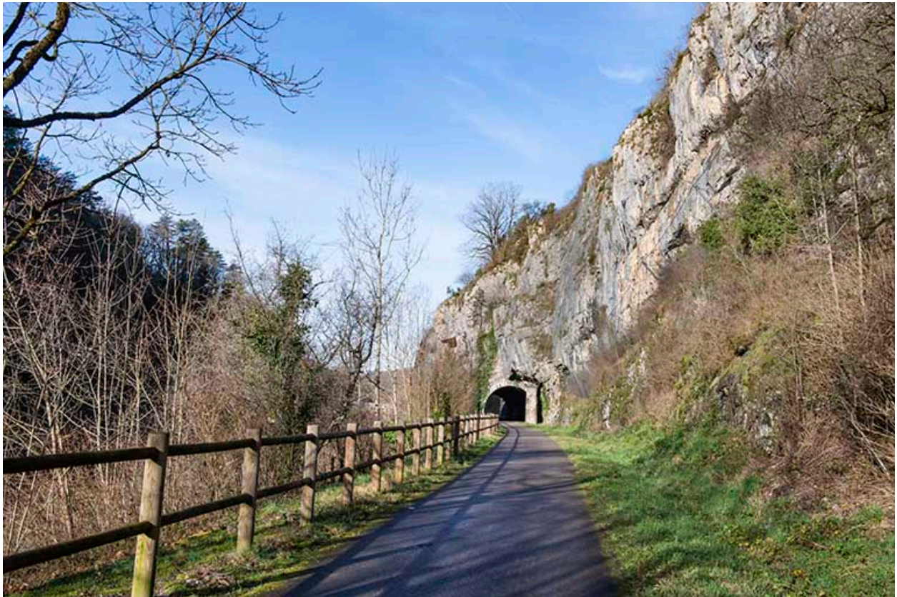
Vue depuis l'est : voie verte et entrée du tunnel.
