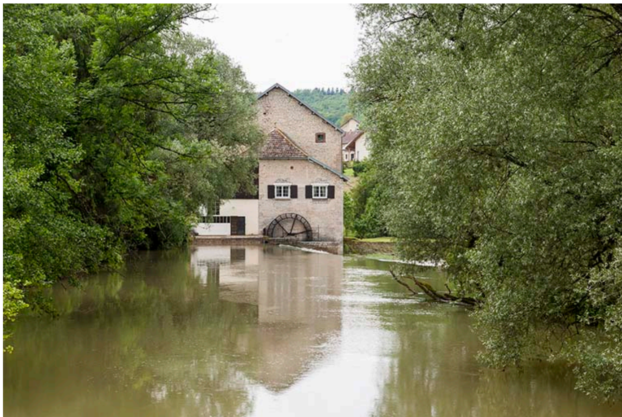
Vue d'ensemble depuis l'amont du Lison.
