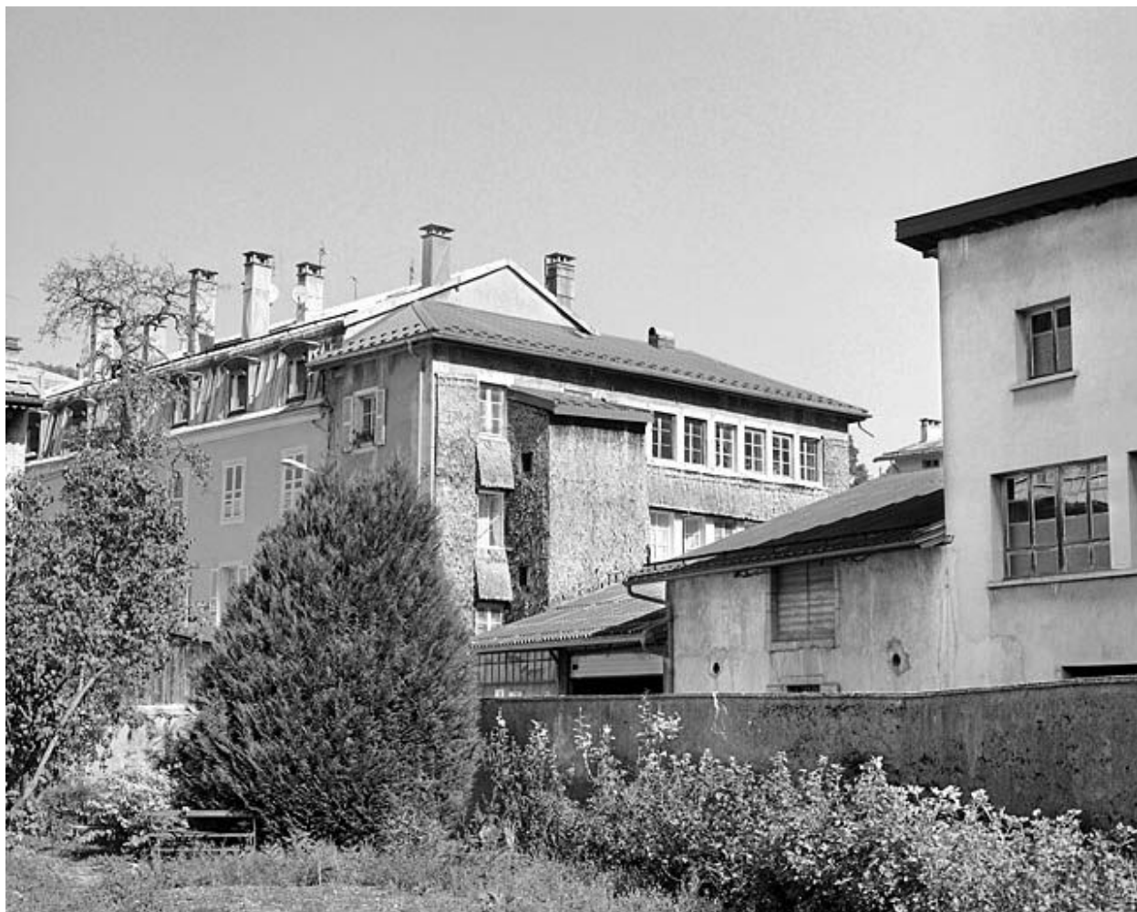
Façades antérieure et latérale droite.
