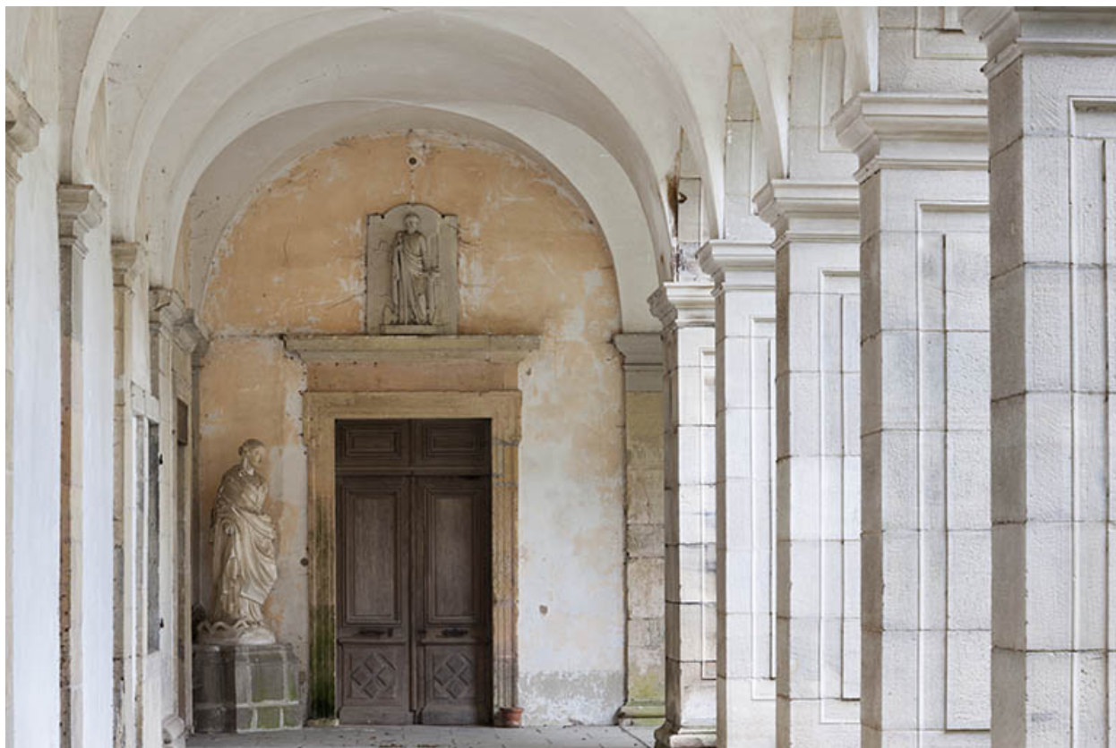
Vue rapprochée de la galerie sud.
