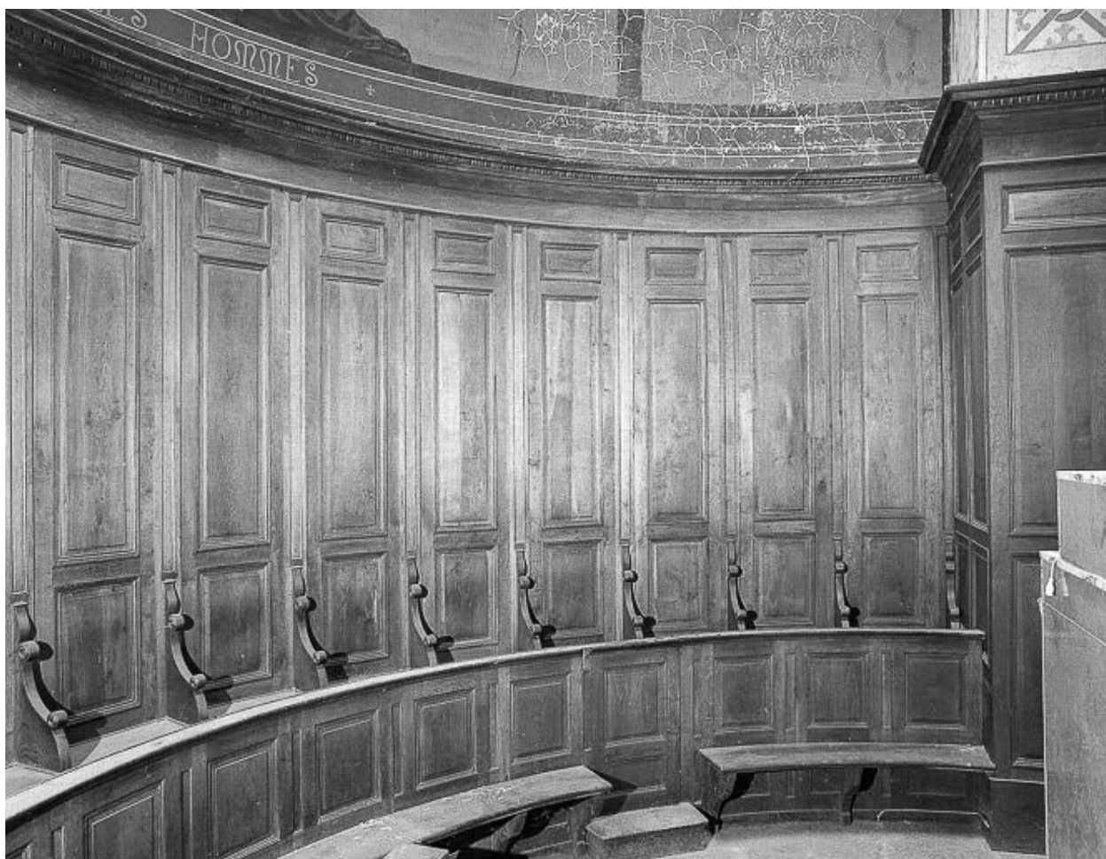
Intérieur : lambris et stalles de l'abside.
