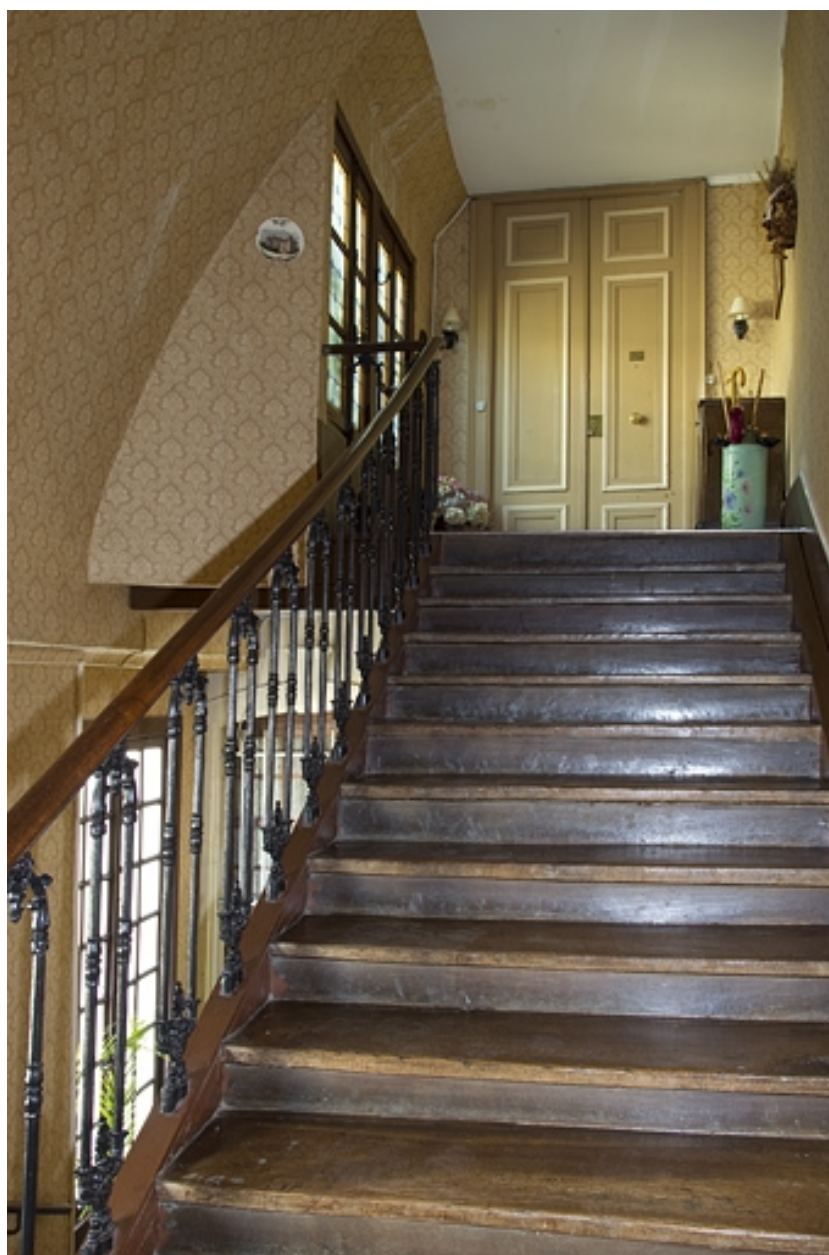
Intérieur de l'escalier : détail d'une volée.
