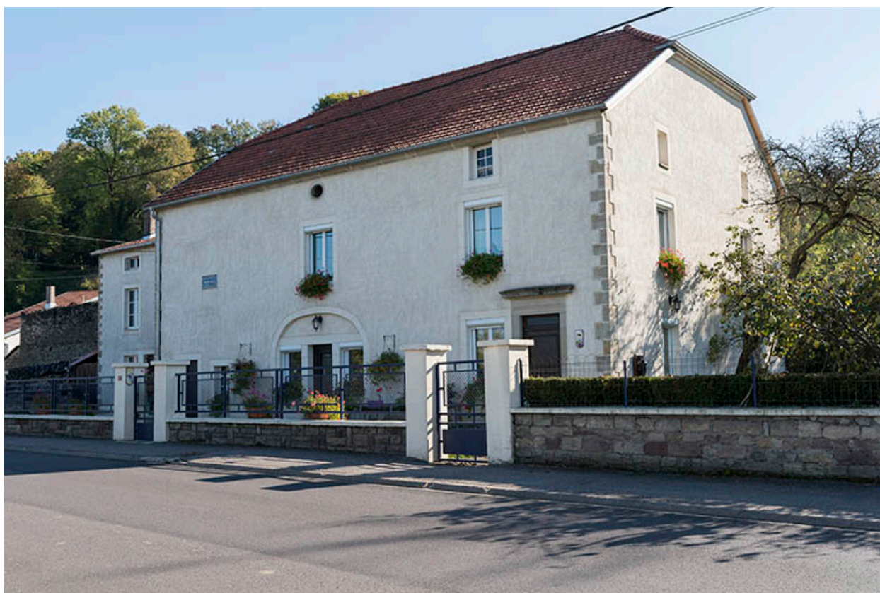
Maison 35, grande rue, vue de trois-quart nord-ouest.
