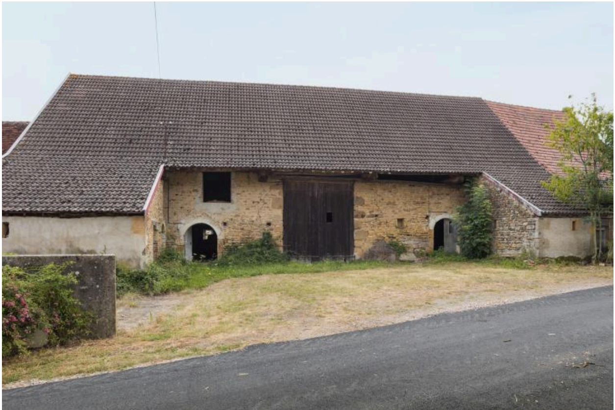
Vue de la façade antérieure de la grange
