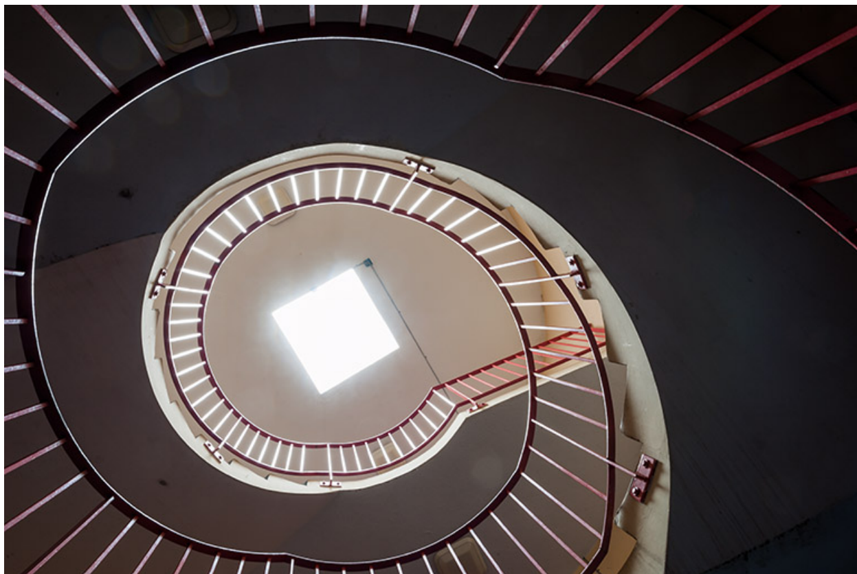
Escalier en vis en béton de l'internat.
