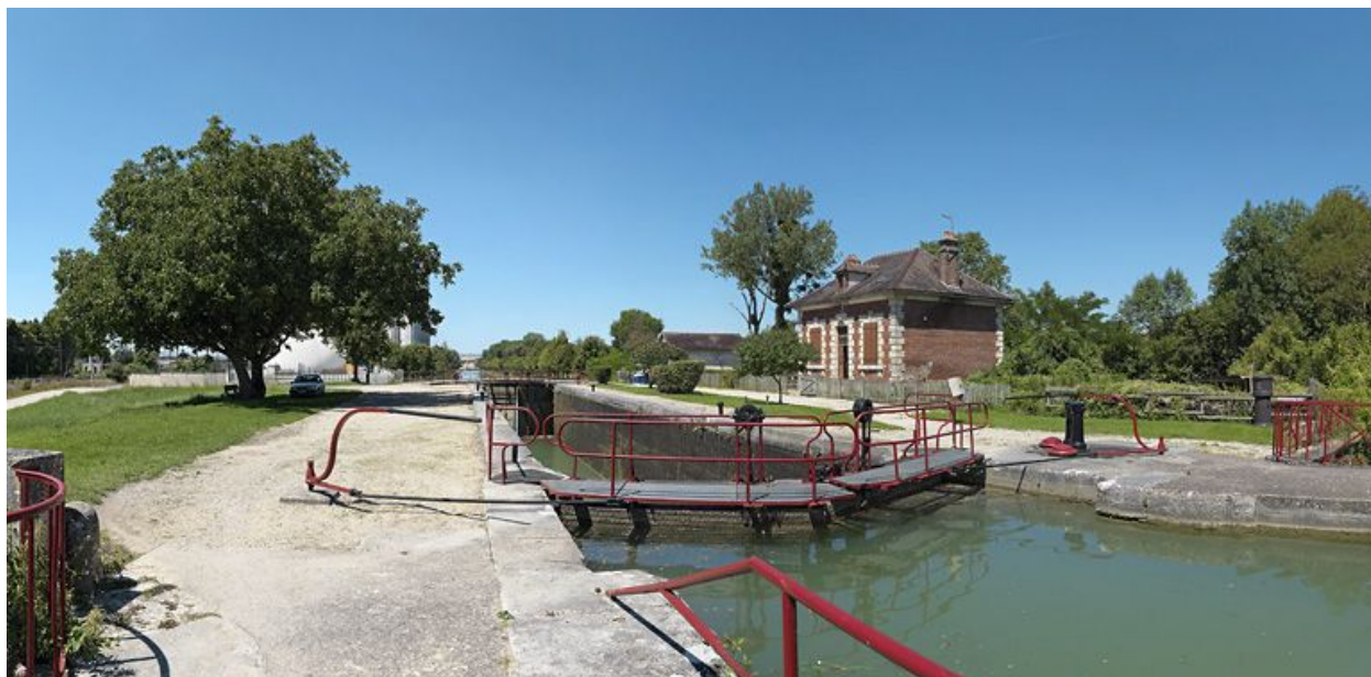
Vue d'ensemble du site d'écluse.
