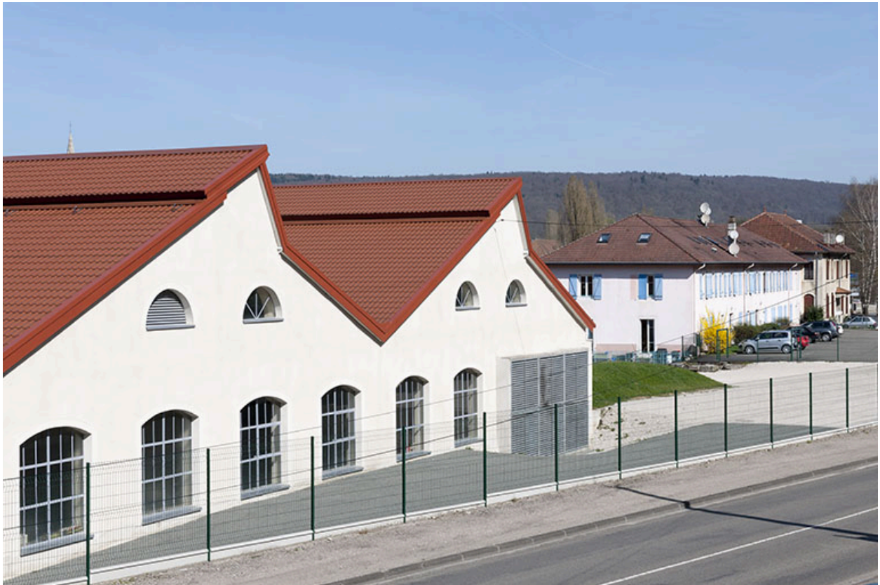
Pignons de la centrale hydroélectrique.
