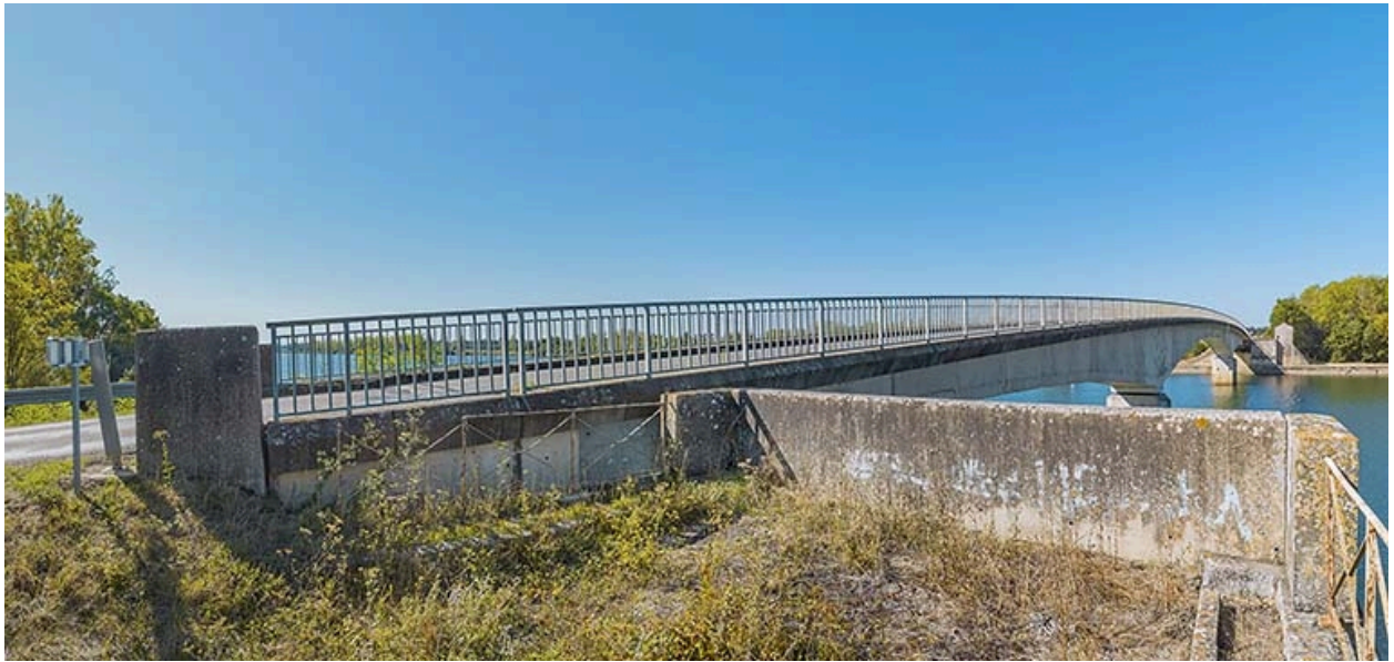
Vue d'ensemble du pont de Thorey depuis la culée de la rive gauche.
