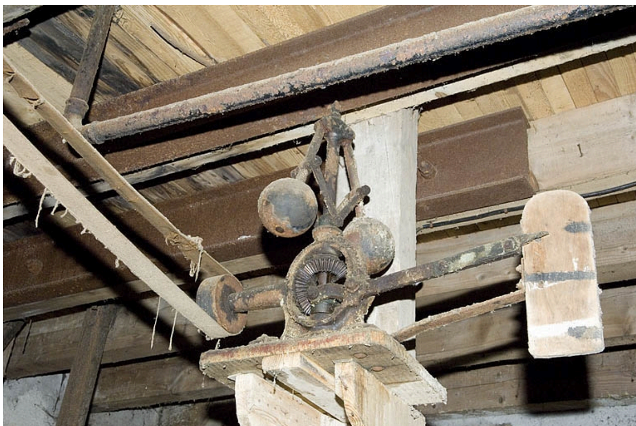
Régulateur à boules du système de transmission de la de la turbine.
