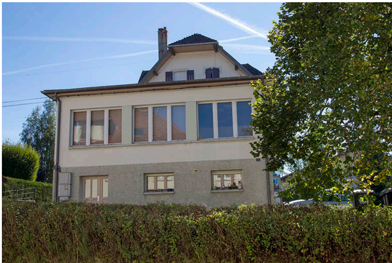
Usine : façade latérale gauche.
