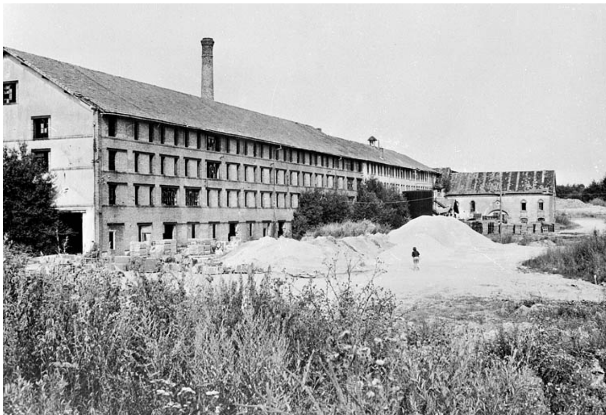
Ancienne et nouvelle tuilerie vers 1980.
