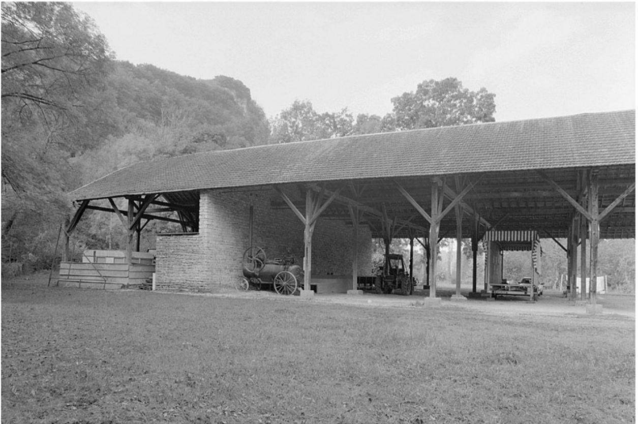
L'entrepôt à merisier.
