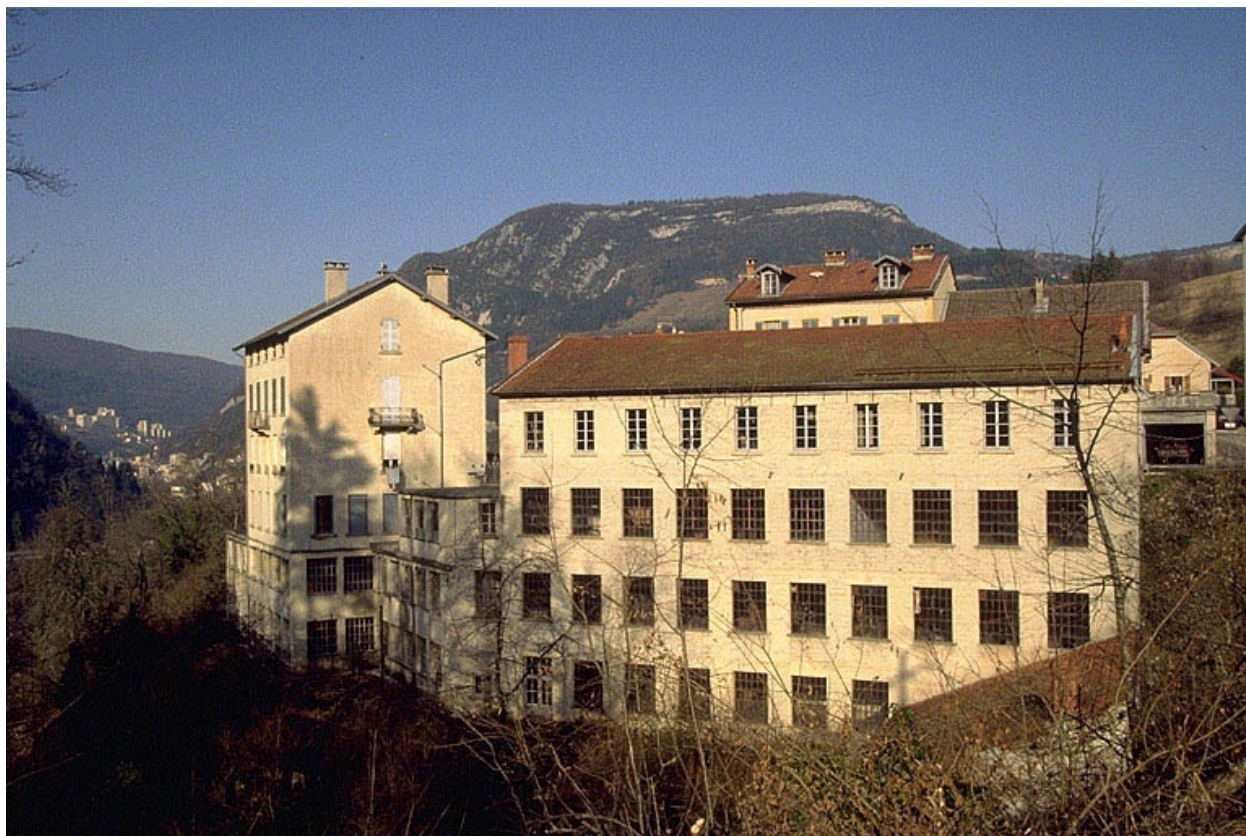
Usine vue du sud.
