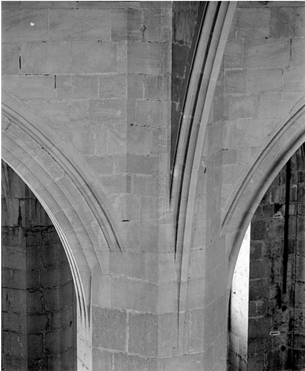
Retombée de l'ogive-diaphragme du vaisseau central sur la pile VIIN.
