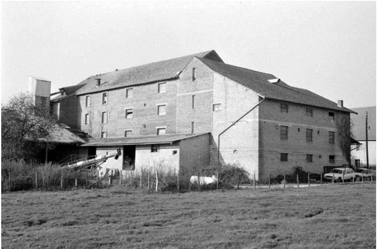
Façades postérieure et latérale gauche.
