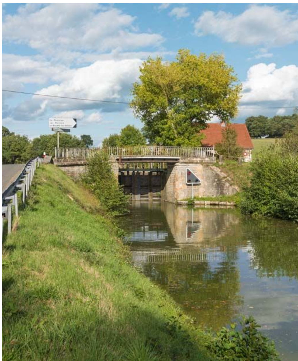
Vue d'ensemble du pont.
