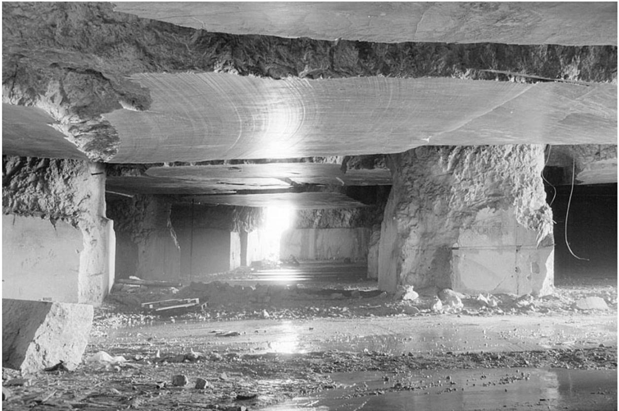
Carrière souterraine de Chassal : galerie latérale.
