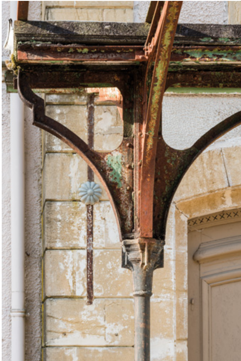
Marquise de la façade sur l'avenue, détail.
