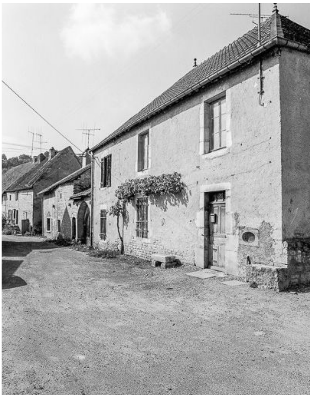
Façade antérieure de l'habitation.
