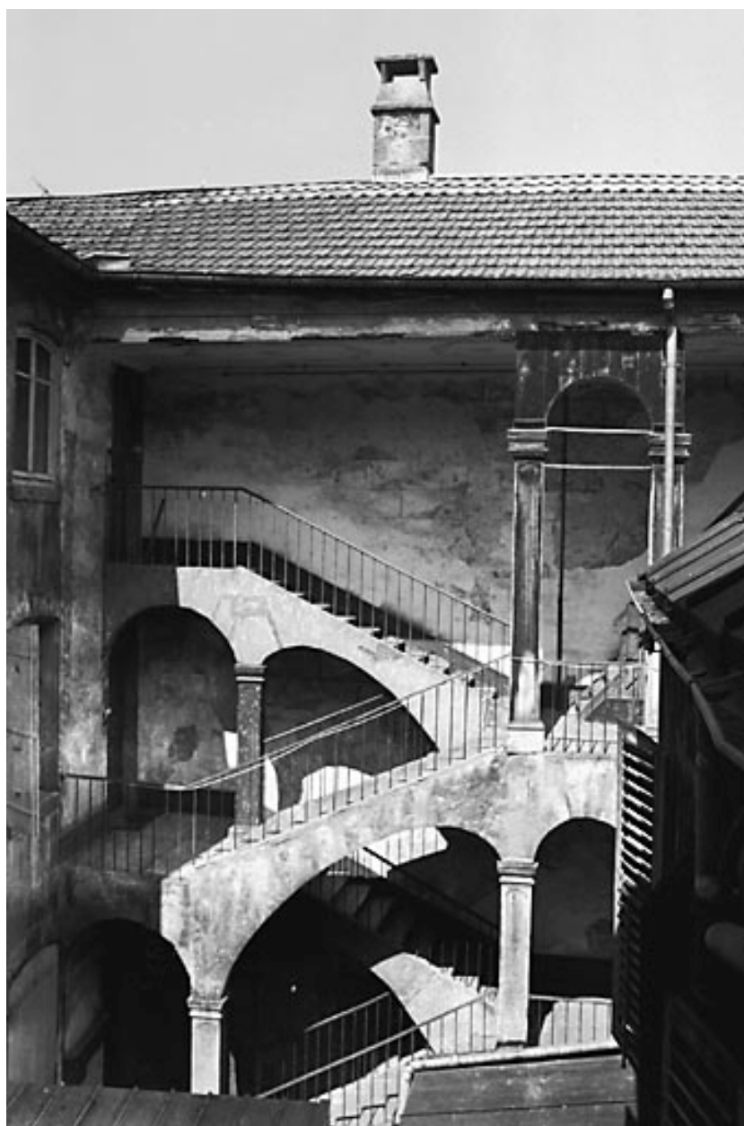
Escalier sur cour intérieure.
