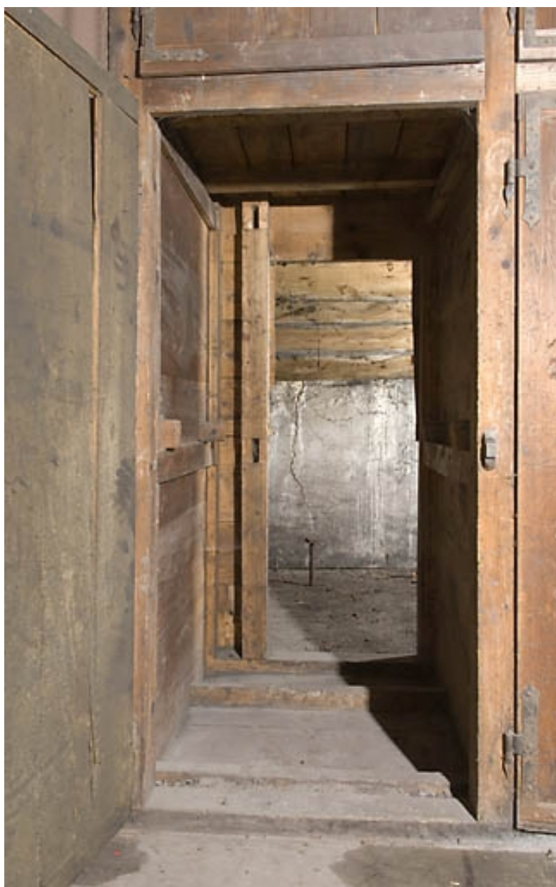
Usine, magasin industriel : placard ouvert.
