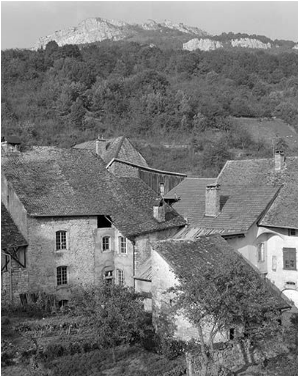
Façades postérieures des maisons cadastrées 1971 AB 376 à 380 de la rue Robert Dame.
