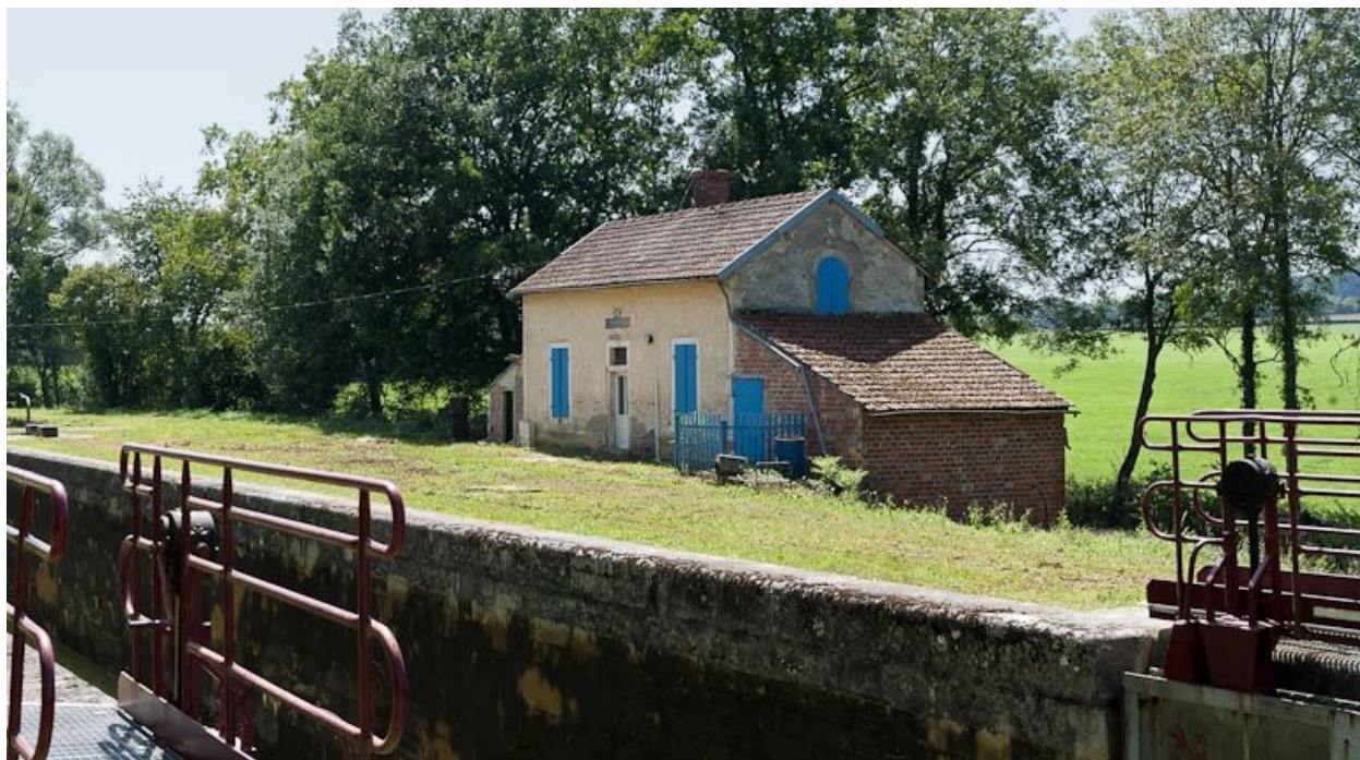
Vue d'ensemble du site d'écluse.
