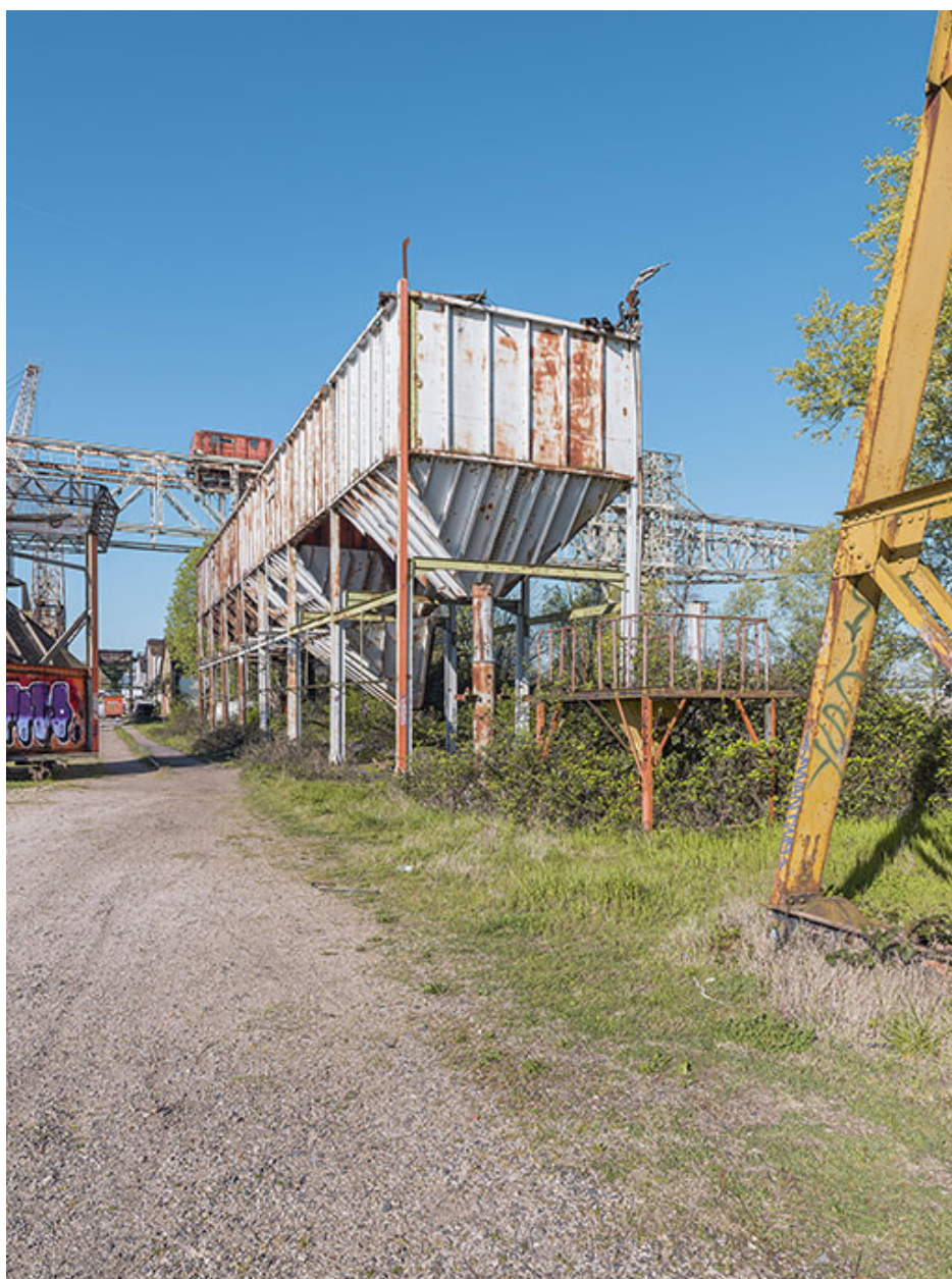
Trémies le long du quai.
