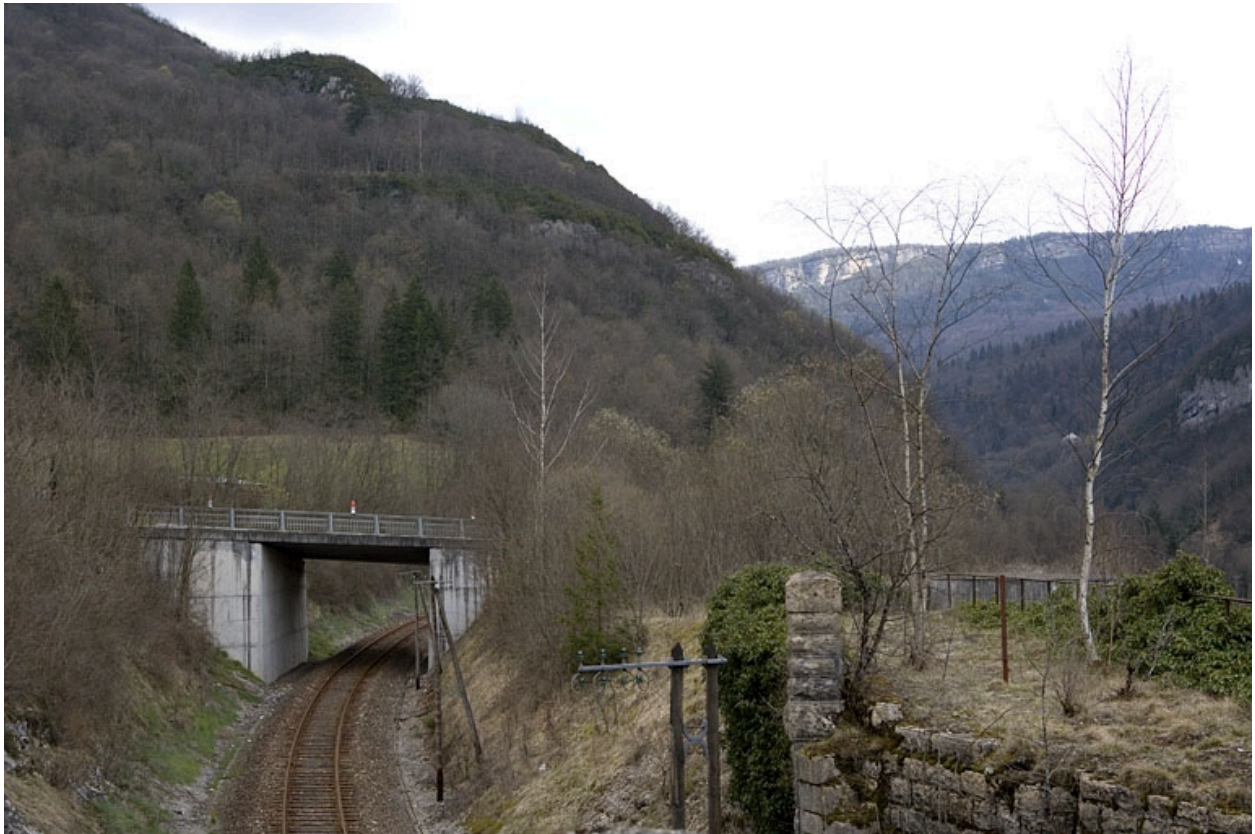
Pont routier, depuis le côté La Cluse (ouest).
