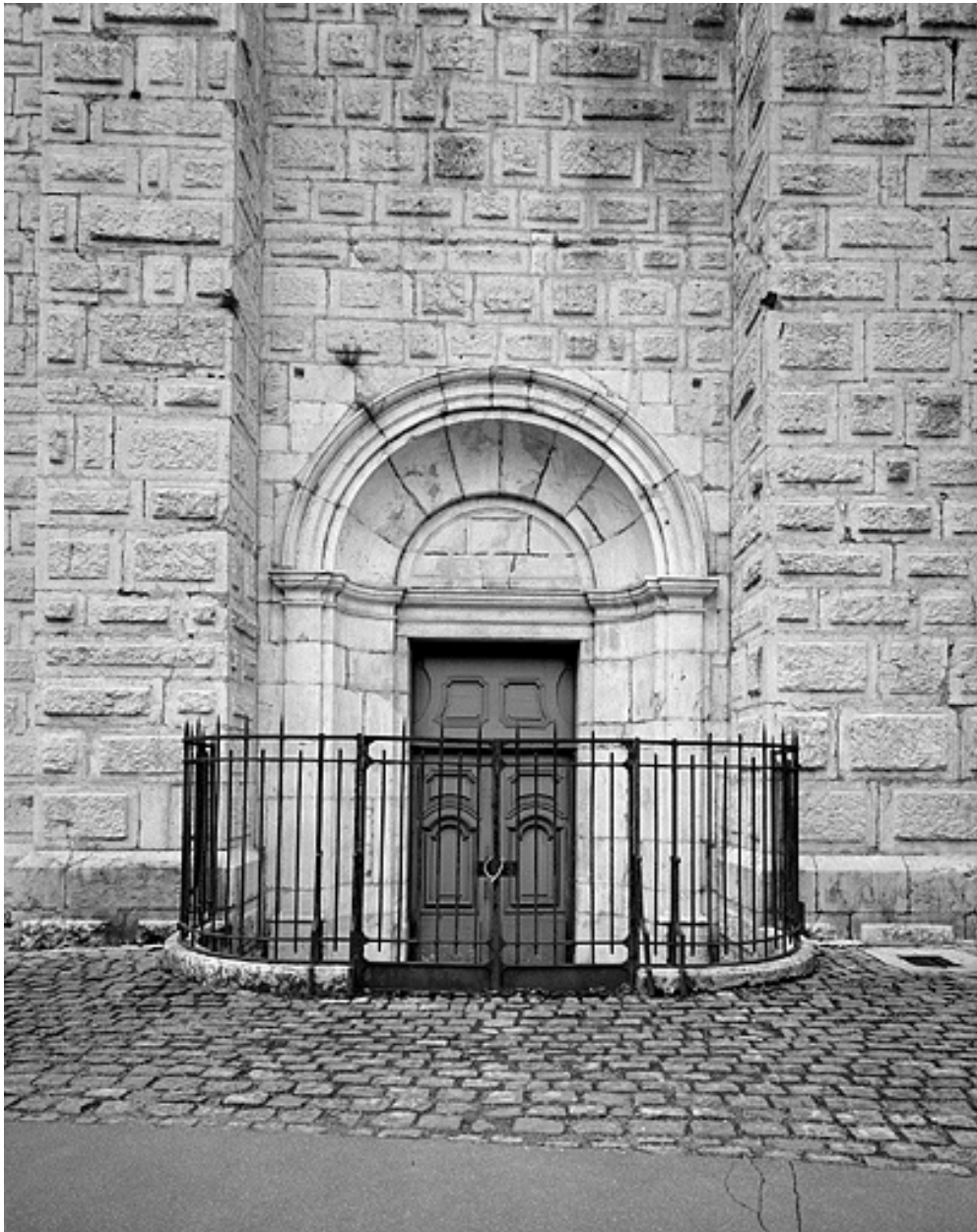
Détail de la porte latérale nord.
