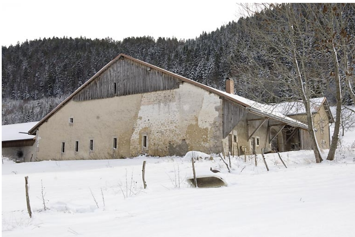
Façade latérale gauche, en hiver.
