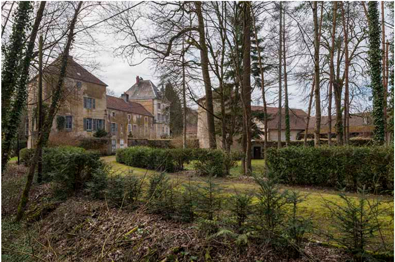
Vue générale depuis le chemin menant à l'usine.
