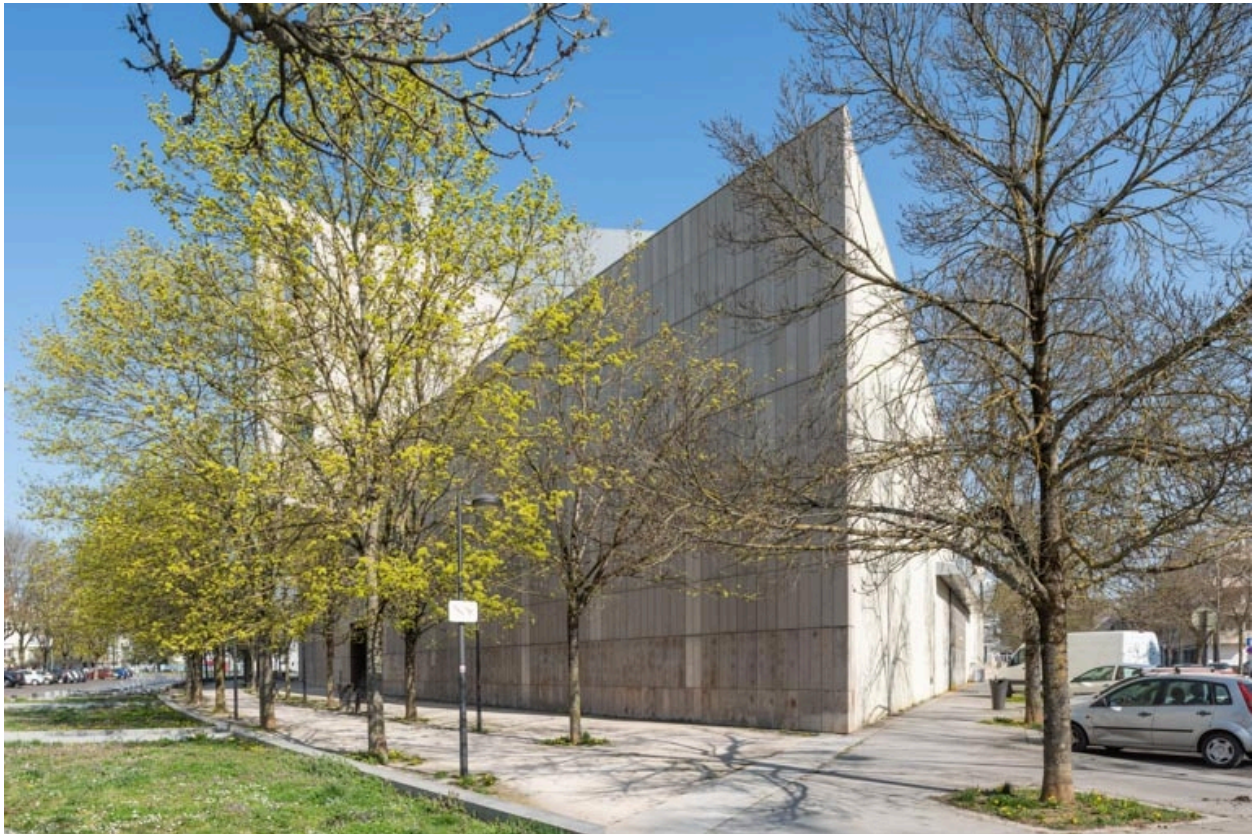
Vue d'ensemble rapprochée, depuis le sud.
