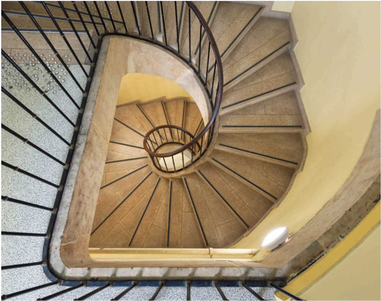
Escalier en vis : vue plongeante oblique depuis le palier de l'étage.
