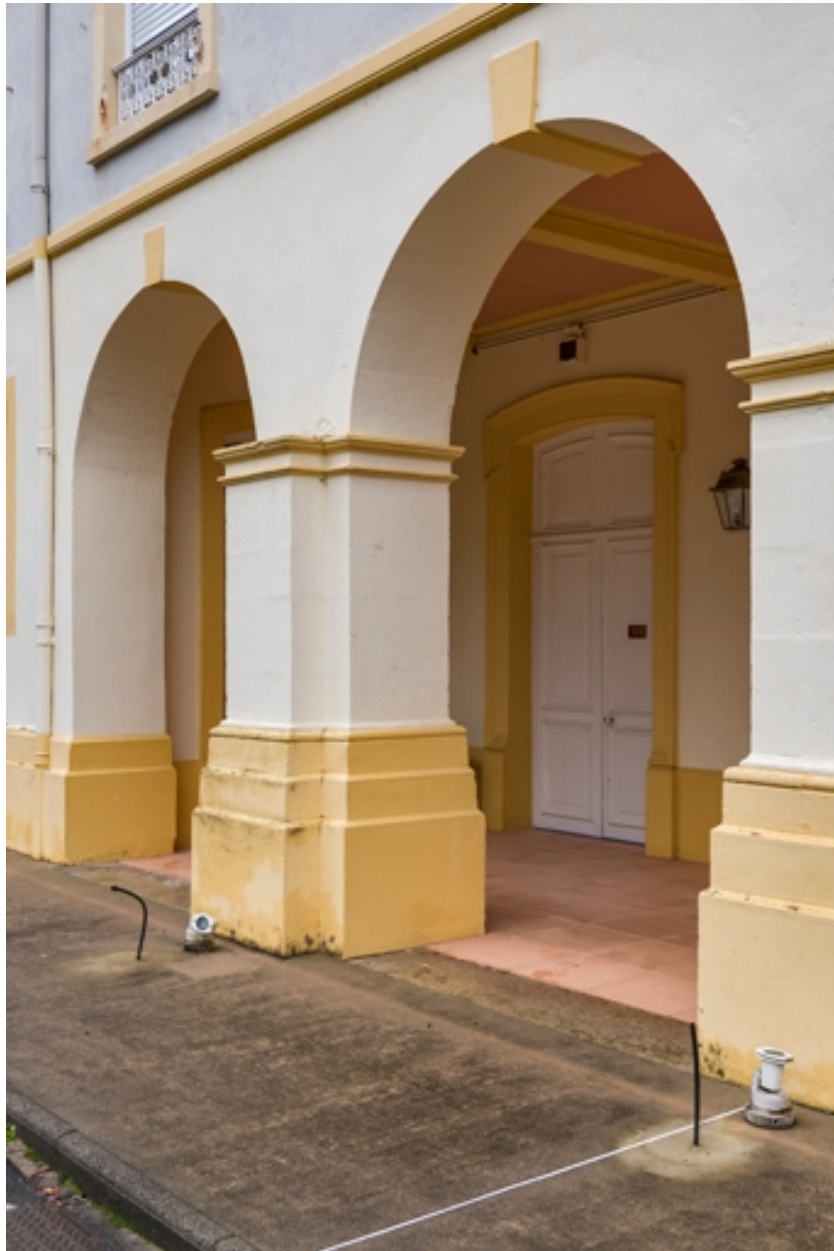
Cour, détail de l'aile nord (arcade en pierre à droite, arcade en ciment à gauche).
