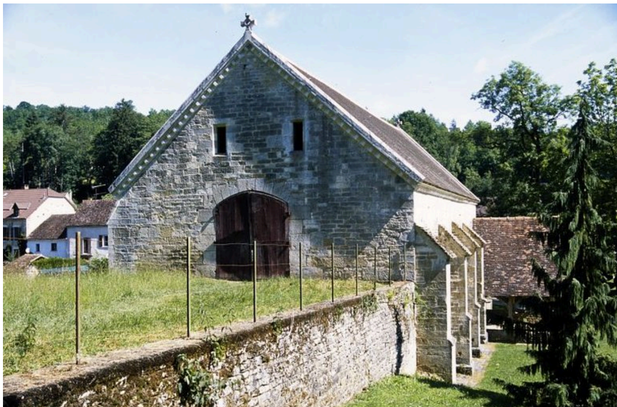
Le cellier, mur-pignon sud.
