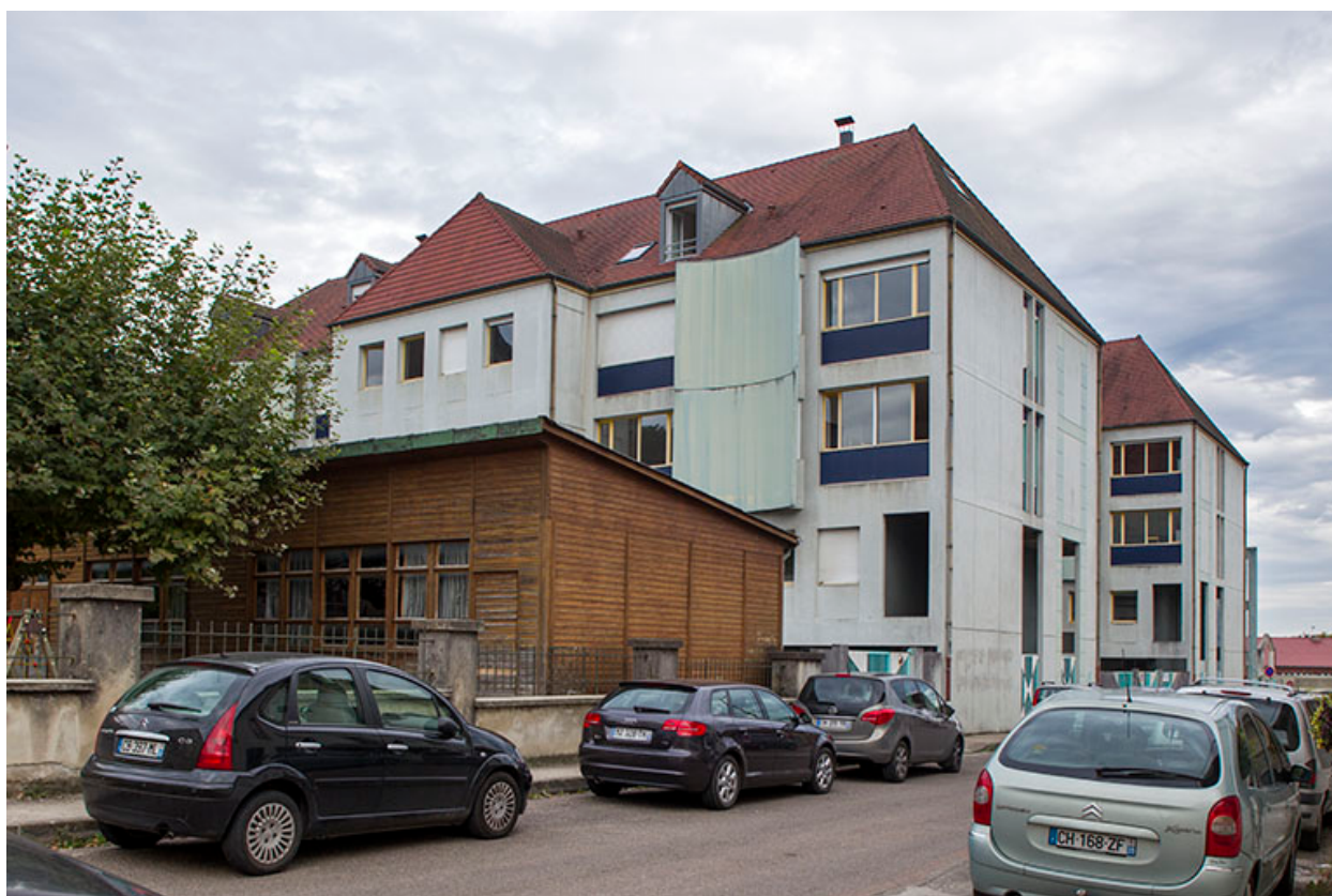
Internat : façades arrière.
