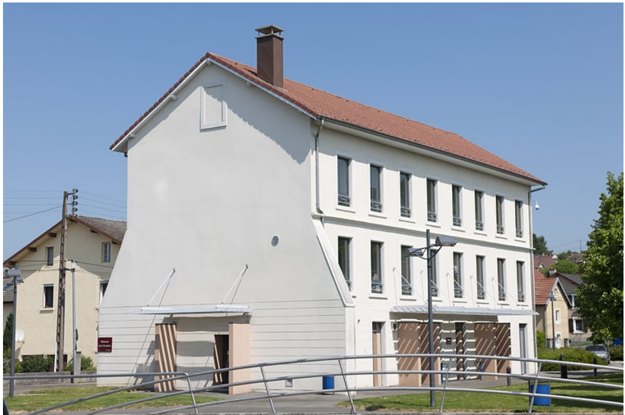
Bâtiment de bureaux. Vue trois quarts arrière.
